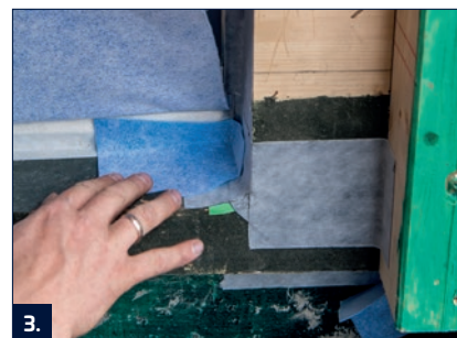
3. A zegzugas sarkokba először szablya be a rendszerhez tartozó megfelelően kialakított sarokelemeket.
