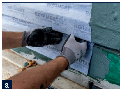
8. Helyezze a PB portál tömítő szalagot a friss RD 2 szigetelésbe, ráncok nélkül. Azoknál az illesztéseknél, ahol nagyobb mozgások várhatók, illessze feszülés mentesen a PB portál szalagot és ha lehet hajtsa és ágyazza be.
