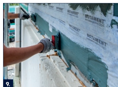
9. Helyezze be a PB portál szalagot ráncmentesen az RD 2 szigetelésbe, a csatlakozásokat bőven dolgozza be az RD 2-vel.
