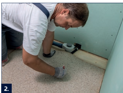
2. Helyezze el a TE Plus hangszigetelő szőnyeget a teljes fa felületre szerelvény csövek alatt.
