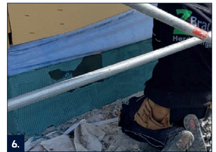
6. Vigyen fel RD 2-t a teljesen kiszáradt karccglettelésre a teljes felületre egy fogazott glettvás segítségével.
