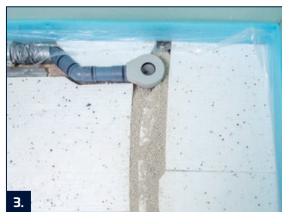
3. Helyezze el a hőszigetelést a TE Plus hangszigetelő szőnyegre a beépítés szintjéhez. A falakon a hanghidak elkerülése érdekében helyezzen el peremszigetelő csíkokat.
