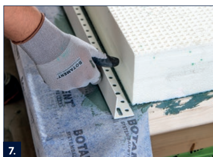
7. Helyezze be a lábazati záróprofilat az RD 2 friss szigetelésbe.
