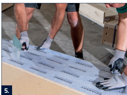
5. A PB portál szalagot ráncmentesen be kell ágyazni a friss RD 2-be.
