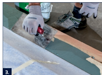
3. Hajtsa fel a PB portál szalagot és karcgletteléssel hordja fel az RD 2-t.
