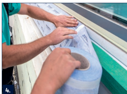
4. Rögzítse a PB portálszalagot a nyílászáróhoz az üntapadós résszel.
