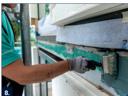
8. Miután a fal elemet az építkezésre szállította, csatlakoztassa a túlnyúló PB portál szalagot az alaplemezhöz vagy az alap szigeteléséhez. Ehhez hordjon fel RD 2-t a teljesen átszáradt karcglettel rétegre.
