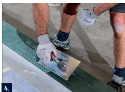
4. A kiszáradt karcglettelésre fogazott glettvassal fel kell hordani az RD 2-t a teljes felületre.
