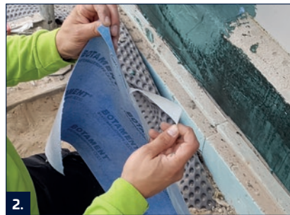
2. A PB szalag hátoldalán lévő ragasztó szalagról húzzuk le a védő részt.
