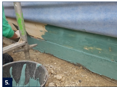
5. Nedvesítse elő a betonfelületek. Vigyen fel karccgletteléssel anyagot a beton és a fa felületekre. Távollítsa el a felesleget.
