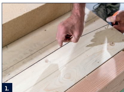
1. Mérje és jelölje be a szigetelés magasságát.
