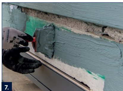
7. Azokon a részeken, amelyeken a portál tömítő szalagot le kell ragasztani, ott az RD 2-t egy kefével vagy fogazott glettvassal vigye fel a felületre.
