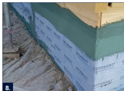
8. Széleket, csatlakozásokat RD 2-vel át kell vonni.
