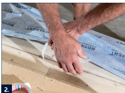
2. Az öntapadó ragasztócsikkal rögzítse a PB portálszalagot.
