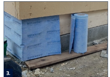
3. A PB szalagot rögzítsük a terepszint fölött 15 cm-rel.
