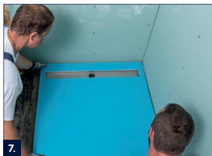
7. Ággyazza be az LD zuhanytálcat vonalmenti lefolyóval, előre gyártott lejtéssel és gyánlag gyártott tömítésekkel a friss esztrichbe, és állítsa be a magasságot és irányt.
