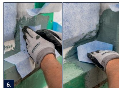
6. Helyezze el a leszabott részeket teljes felületen az RD 2-be és nyomkodja bele ráncok nélkül.
