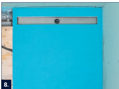
8. A teljes rétegfelépítést vágja le a későbbi megmunkálásához a zuhanytálccával egy síkban.
