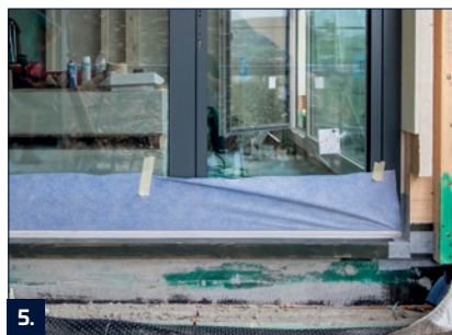
5. A munkafolyamat megkönnyítése érdekében ideiglenesen ragasztószalaggal ragasszuk fel a PB portál szalagot az ablakra.
