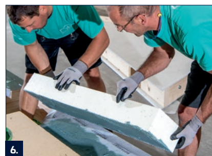
6. Kétoldali kenéssel ragassa fel a lábazati hőszigetelő anyagot RD 2-vel.
