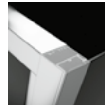
Ajtó profil csatlakozása az oldalfallal.
